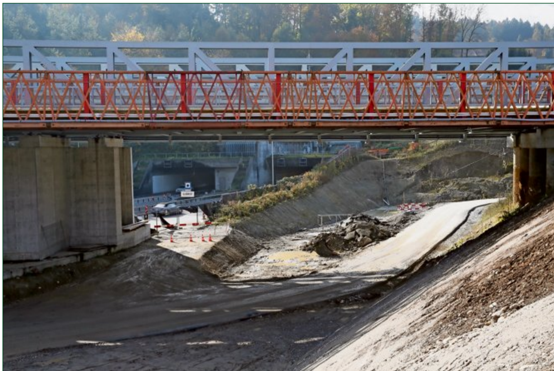
Die dritte Röhre wird rechts neben den beiden bestehenden liegen. Ab dem Jahr 2022 werden hier drei Fahrspuren unter den provisorischen Brücken zum Portal (hinten angedeutet) führen. Bild: Sibylle Meier
